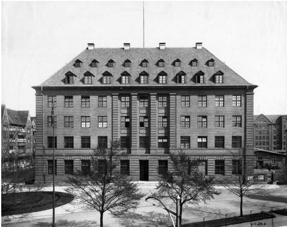
Abbildung 5: Das zentrale Forschungslaboratorium (1924)
